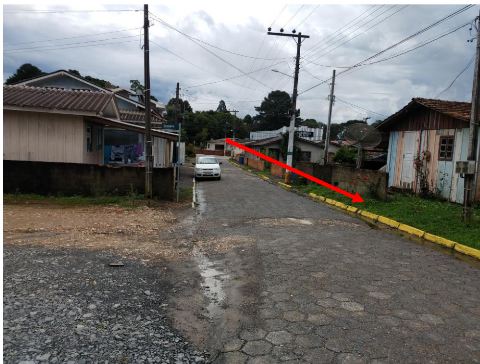
Foto 07- Término da calçada nova
