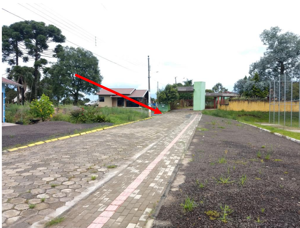
Foto 10- Será realizado passeios no lado esquerdo até o final da rua Juvenal de Farias
